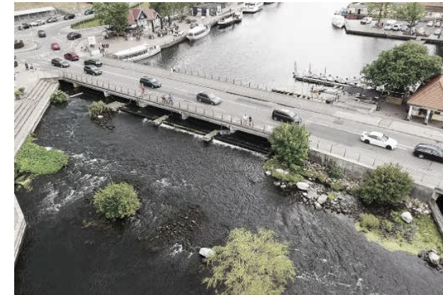
I Silkeborg er sluseanlægget kombineret sluse, faunapassage og vejbro
