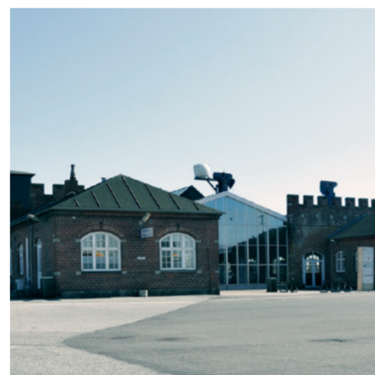
Gedser Station som i dag bruges som ankomst- og afgangshal af Scandlines
