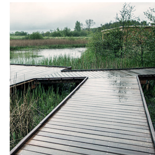
Eksempel på boardwalk til alle brugere
